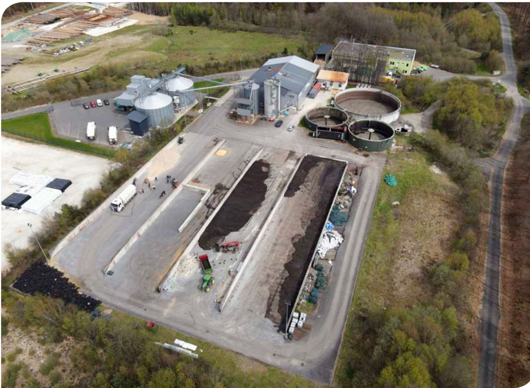
Die letzten Gärfeststoffe der stillgelegten Biogasanlage Hammelbüsch lagern in den Fahrsilos. Sowohl Fermenter und Nachgärer (im Hintergrund die kleineren Behälter rechts und links) als auch das Gärproduktlager (dahinter) sind entleert. Die Anlagen links davon gehören nicht zur Biogasanlage.
