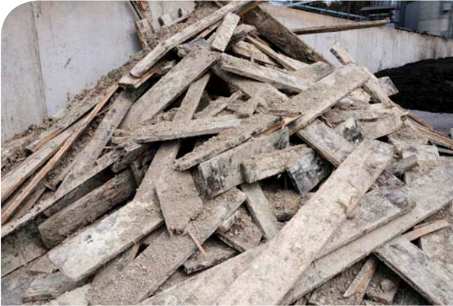
Mit Schwefelablagerungen sind die Bohlen des Gebälks überzogen.
