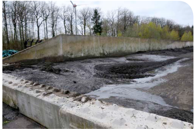
Die festen Ausbaggerungen lagern noch in den Fahrsilos, um von den Landwirten abgeholt zu werden.
