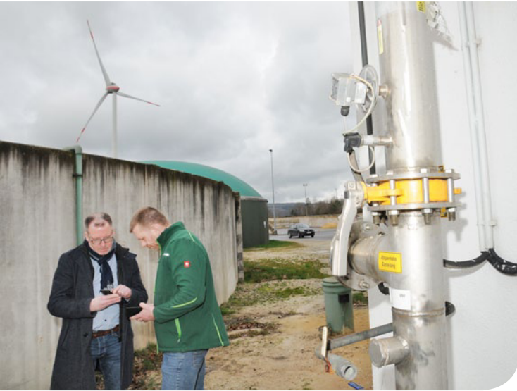
Die bisherigen Anlagenteile befinden sich in unterschiedlich gutem Zustand. Wo möglich sollen Teile wiederverwertet werden.
